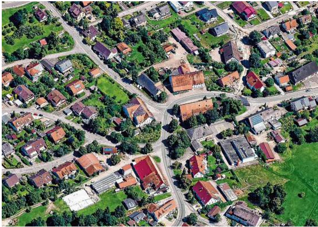
Ein Blick von oben auf Überauchen, das ein neues Gesicht bekommt. Mit dem Abriss des Gasthauses Kranz und des Schlachthauses hat der Wandel begonnen. BILD: HANS-JÜRGEN GÖTZ
