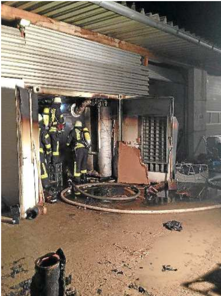
In Brigachtal brannte am Samstagmorgen die Abgasanlage einer Biogasanlage. Foto: Eichkorn Foto: Schwarzwälder-Bote
